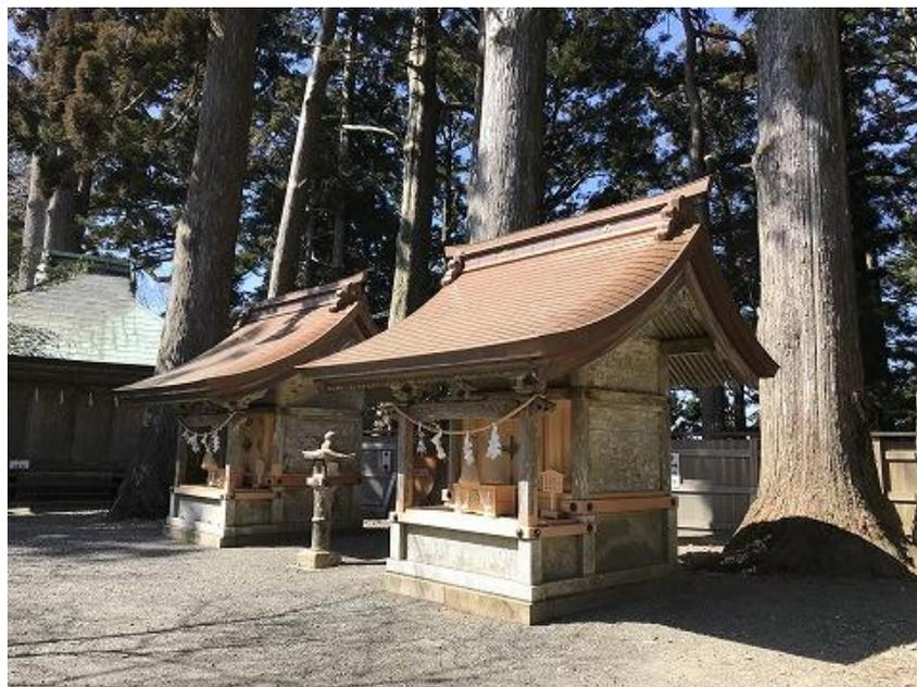
令和2年10月19日竣工。屋根の葺き替え、劣化した柱の入替及び土台の通気性の向上を行いました。
